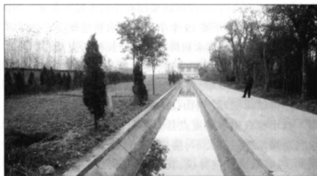
如皋市如城镇渠道衬砌后过流能力大大提高
