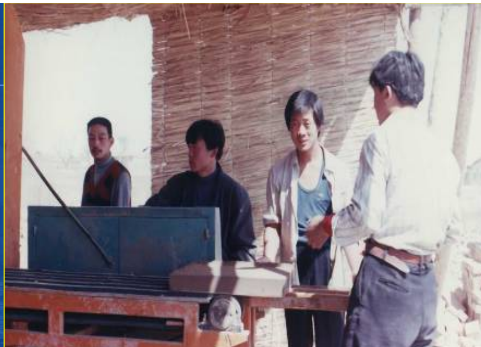
一千灌域东一支渠土壤固化板衬砌施工（1999年施工）
