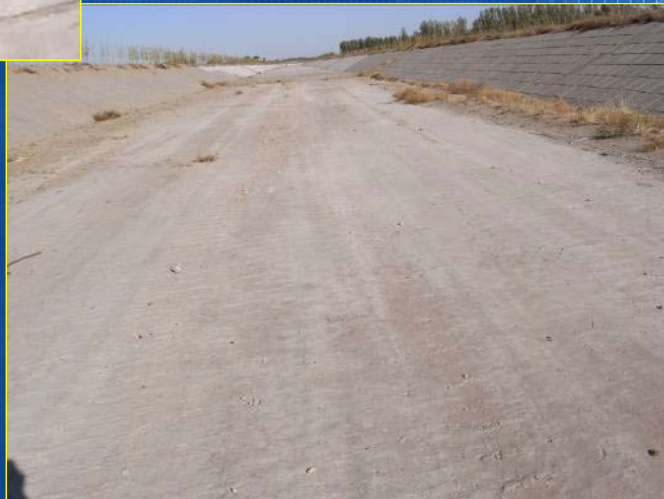
西辽河灌区干渠固化土 渠底现浇试验段（2006年）
