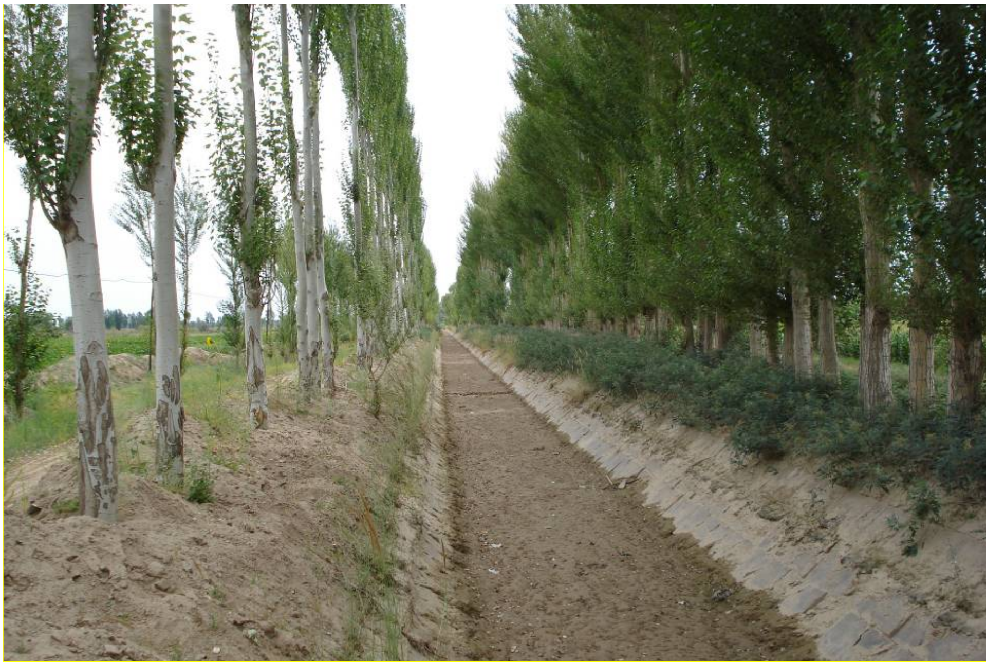
隆胜节水示范区西济渠右五斗渠土壤固化板+塑膜衬砌（1999年施工）
