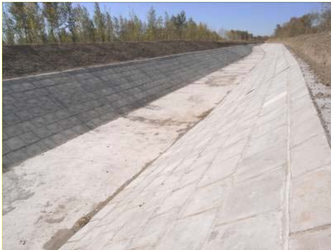
西辽河灌区干渠固化土 渠底现浇试验段（2006年）
