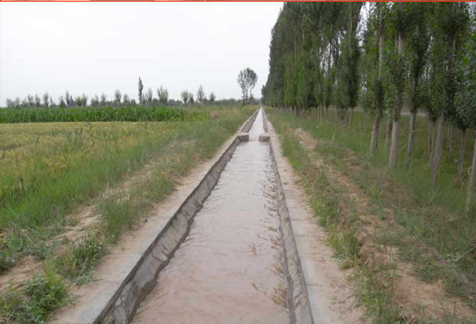
农渠膨润土防水毯衬砌施工与灌溉运行（2007年）
