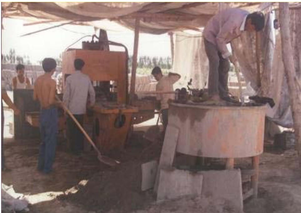
一千灌域东一支渠土壤固化板衬砌施工（1999年施工）
