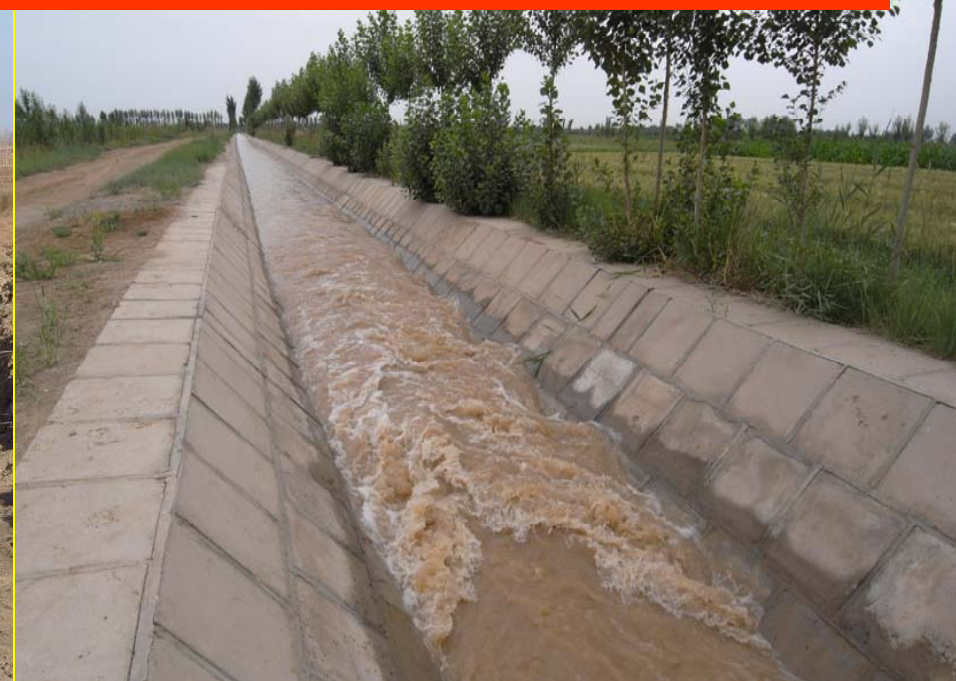
公安斗渠土壤固化板预制、施工、观测与灌溉运行（2007年）
