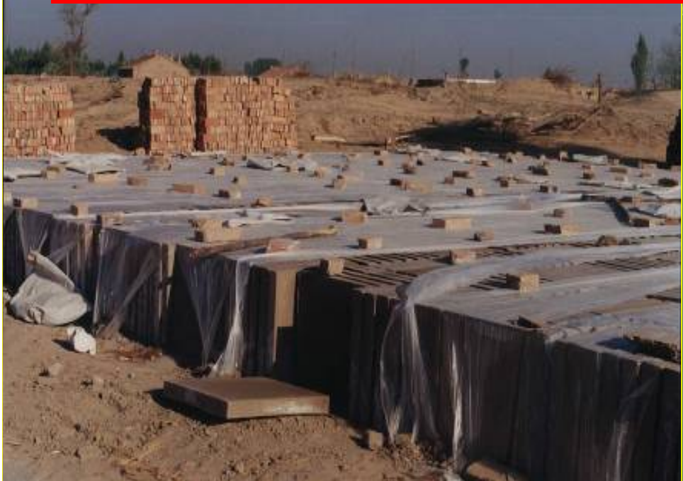
一千灌域东一支渠土壤固化板衬砌施工（1999年施工）
