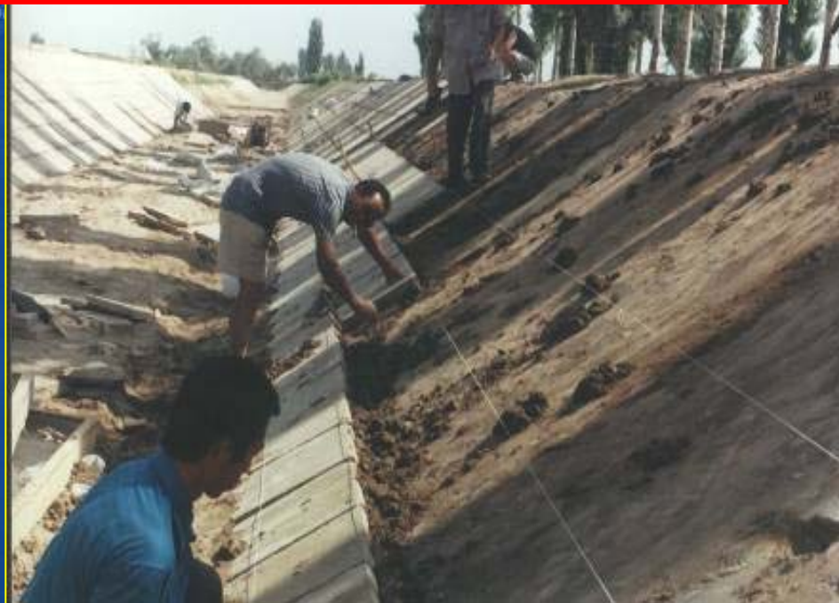
一千灌域东一支渠土壤固化板衬砌施工（1999年施工）
