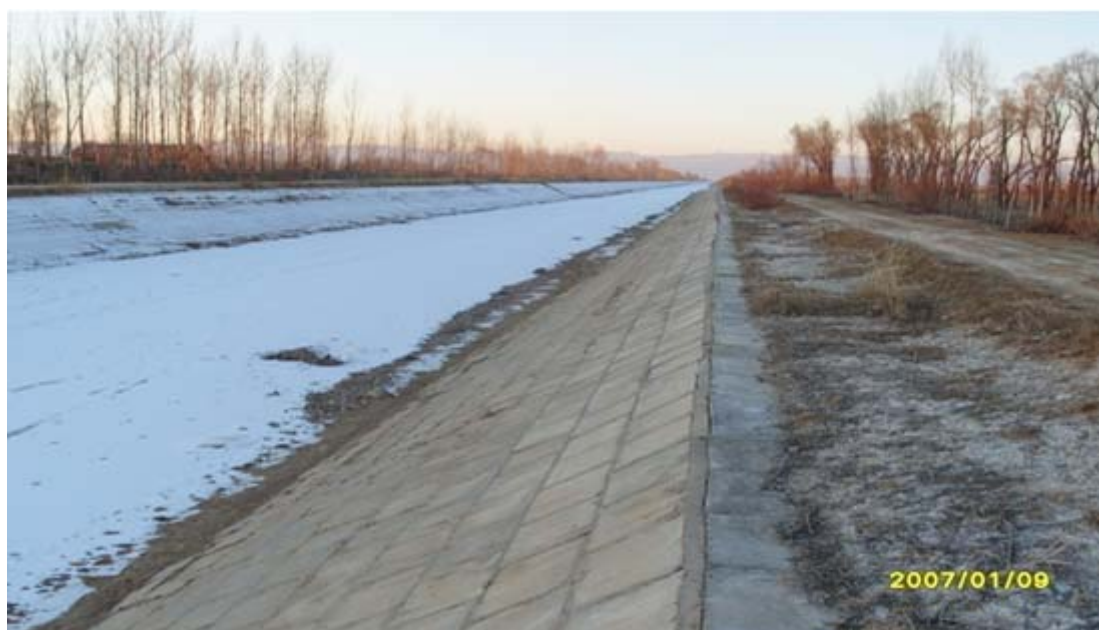
图 5 杨家和干渠采取保温措施的试验段（已运行 7 年）
