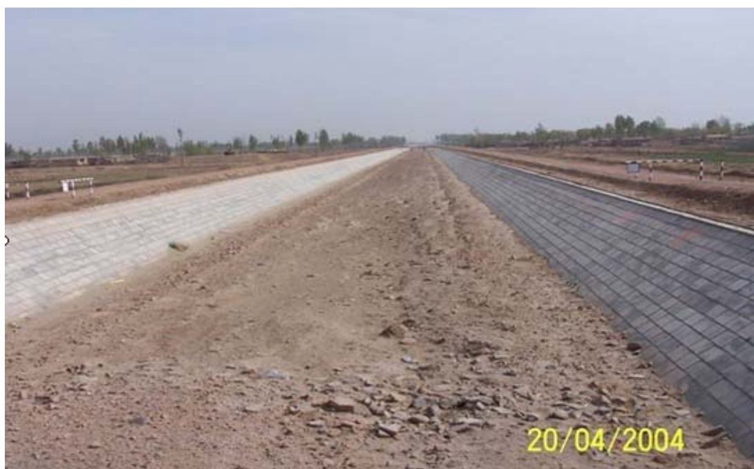
图 6 和干渠 2001 年度项目采取保温措施的工程段落（运行 2 年后）
