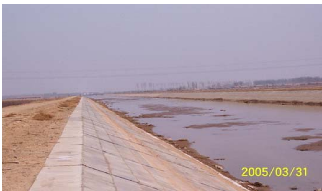
图 7 永济干渠（2001 年度项目）采取保温措施的工程段落（运行 3 年后）
