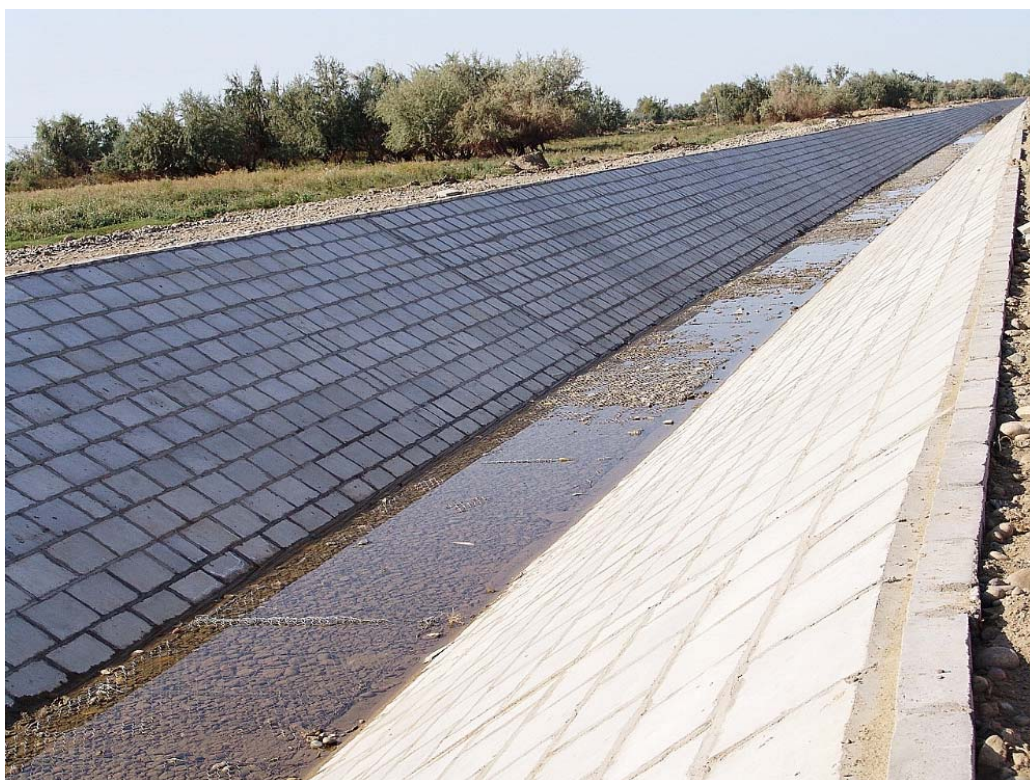
雷诺护垫铺设后渠道
