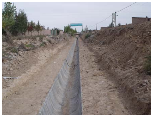
支干渠 U 形断面
