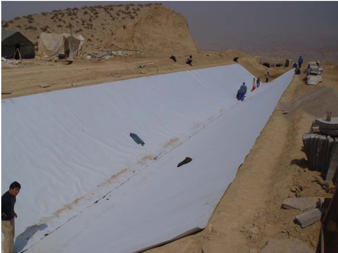
干渠防渗采用复合土工膜铺设现场
