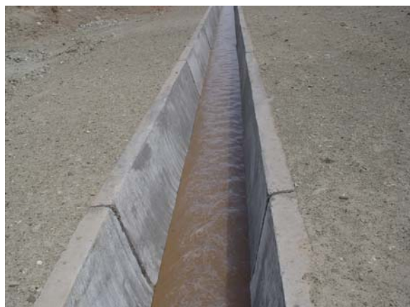
支干渠 U 形断面
