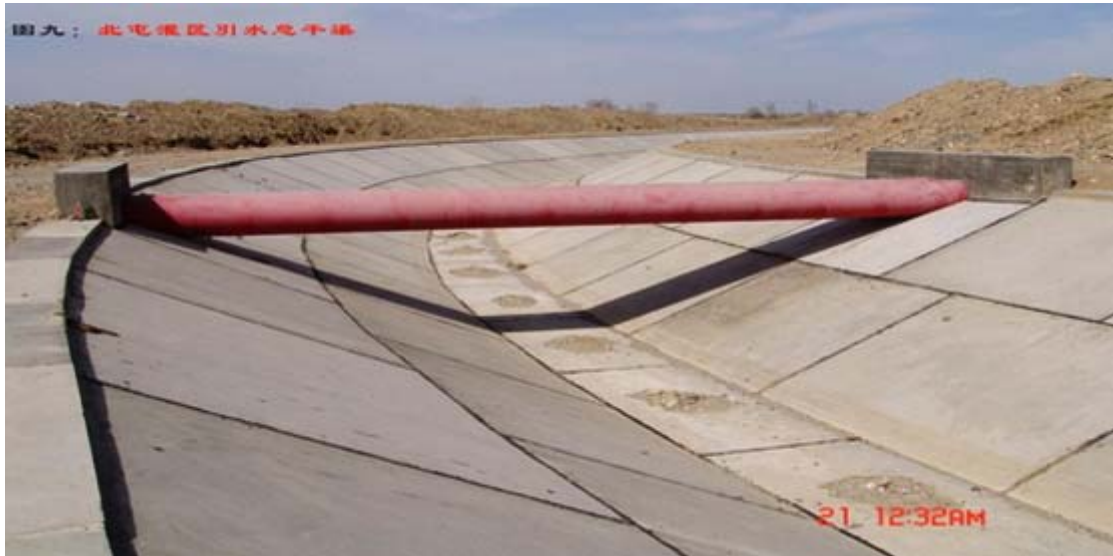
已运行七年的总干渠
