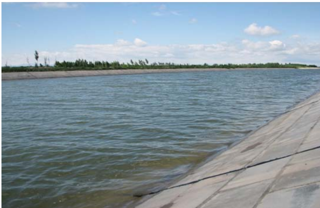
图 8 永济干渠（2001 年度项目）采取保温措施的工程段落（运行 6 年后）
