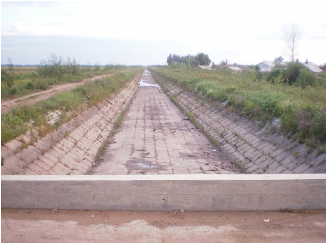
预制混凝土板衬砌渠道
