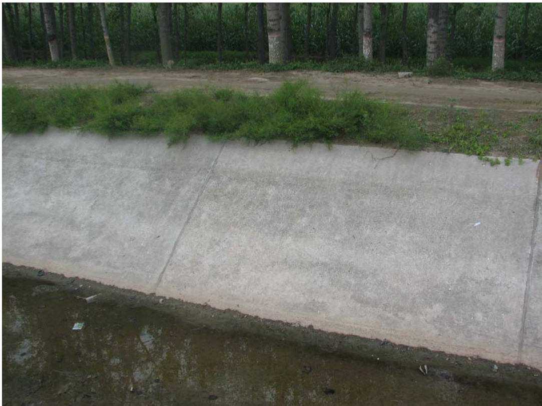
一千五分干渠混凝土防渗工程实景图（6cm 厚）
