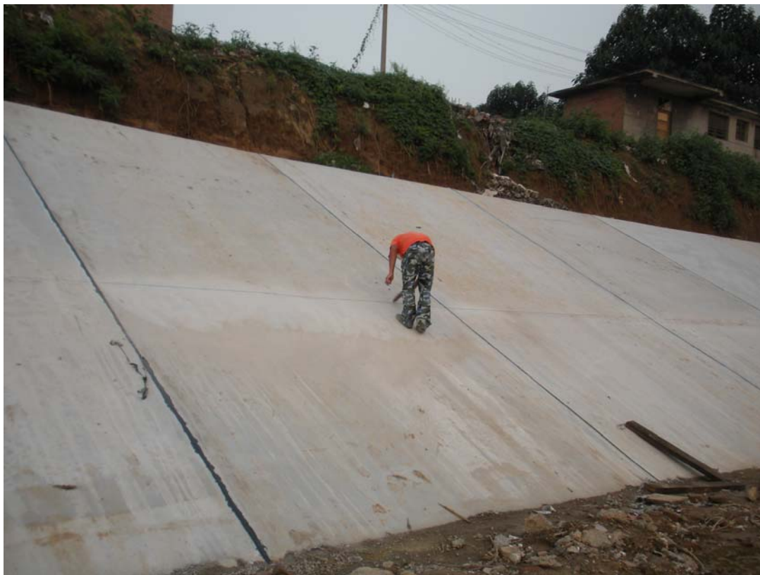
总干渠田庄段混凝土防渗工程实景图
