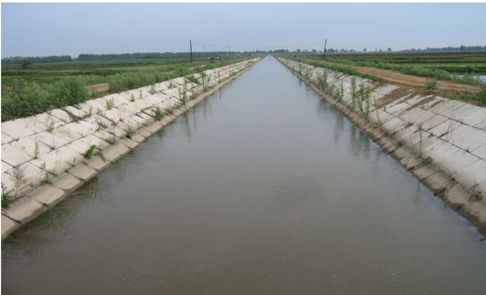
伏胜干渠照片
