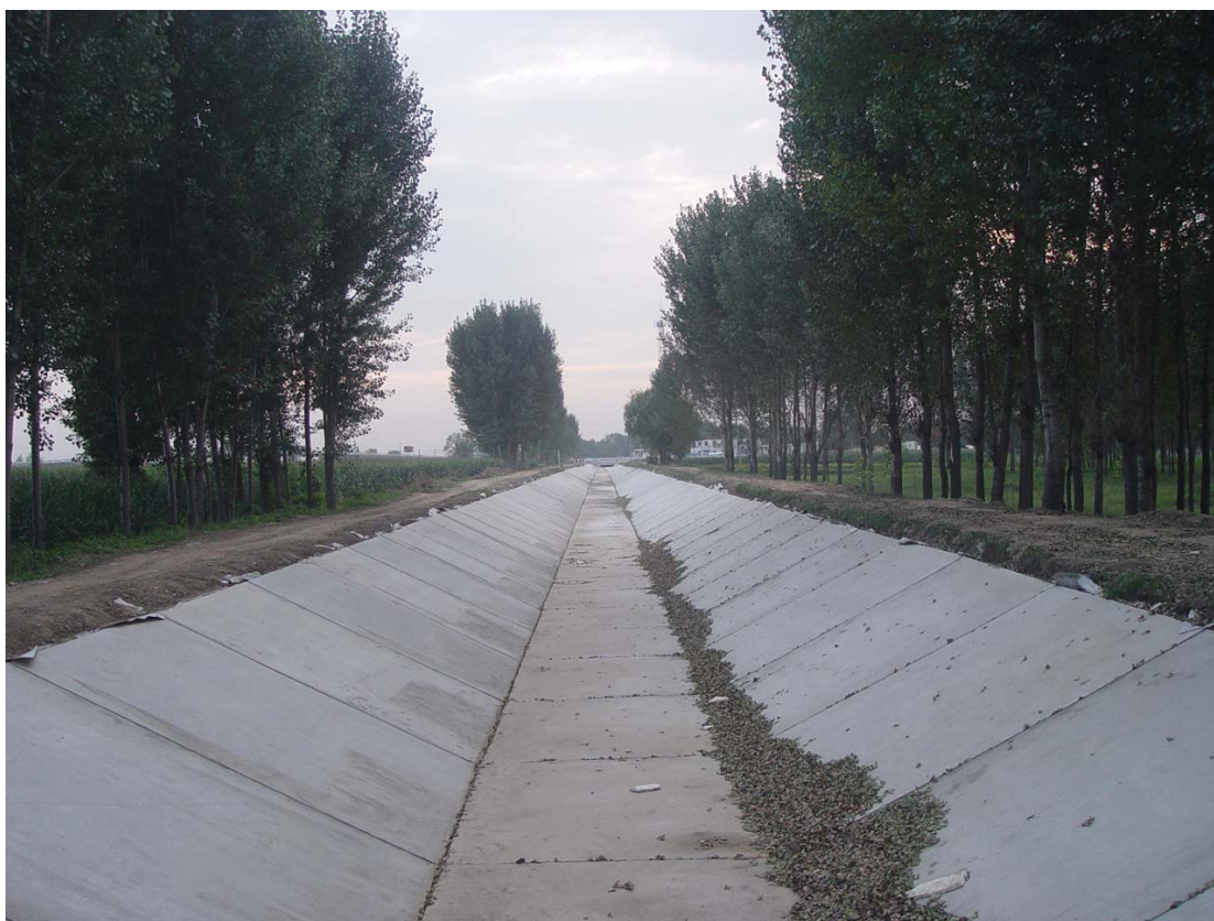
四千二分干渠混凝土防渗工程实景图
