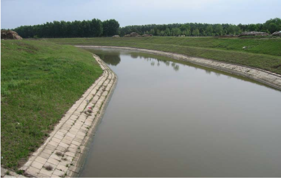
引汤总干解放岗渠段
