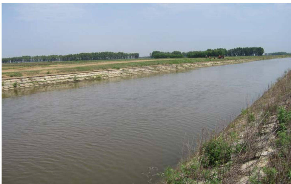
引汤总干渠照片
