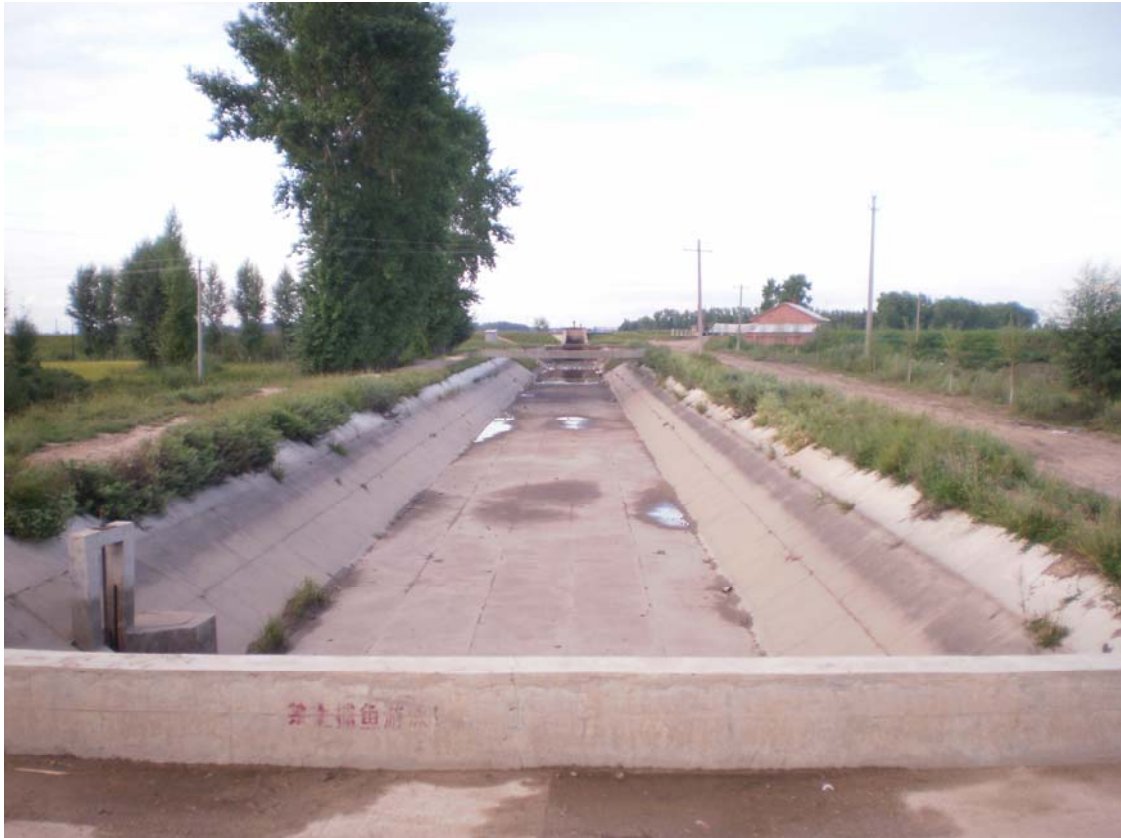
现浇混凝土渠道
