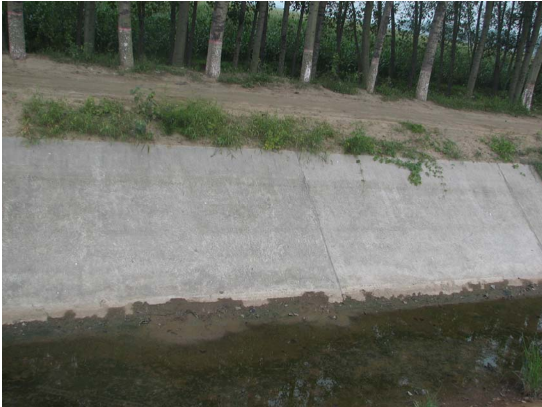
一千五分干渠混凝土防渗工程实景图（6cm 厚）
