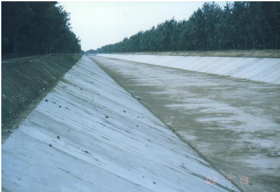
军干渠混凝土防渗工程实景图
