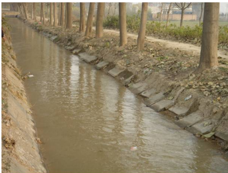
图 2-7 渠坡基土冻融滑坡导致预制混凝土板滑塌破坏照片 (2)
