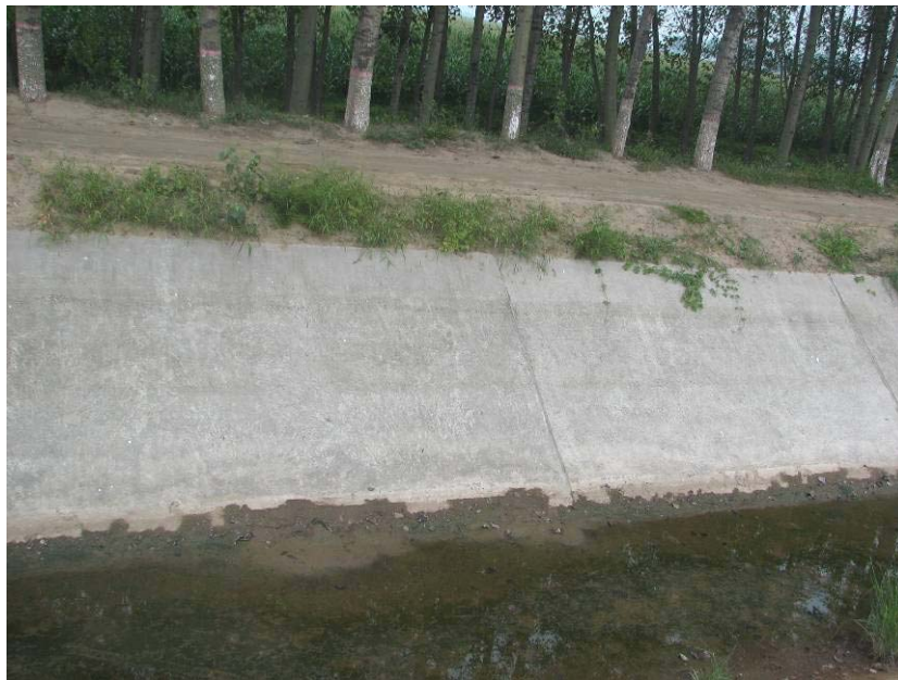
图 3-54 一千五分干渠混凝土防渗工程实景图（ 6\text{cm} 厚）
