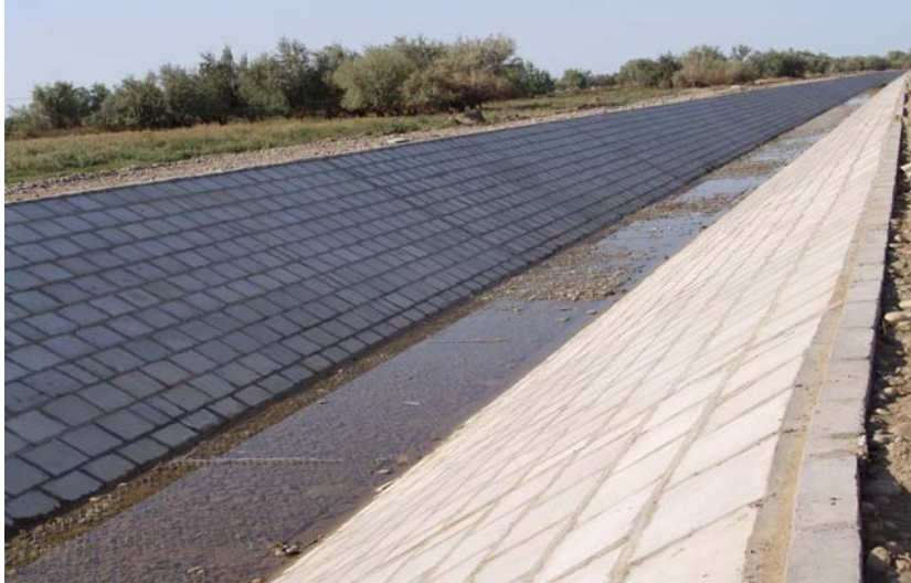
图 3-4 渠底采用柔性防护型式的北屯灌区三千渠（已运行 6 年）
