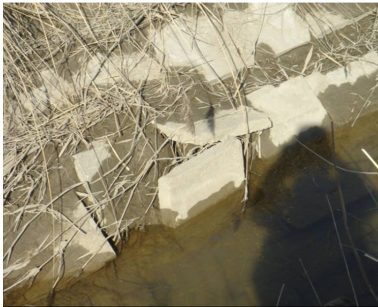
图 2-3 混凝土衬砌板隆起架空照片
