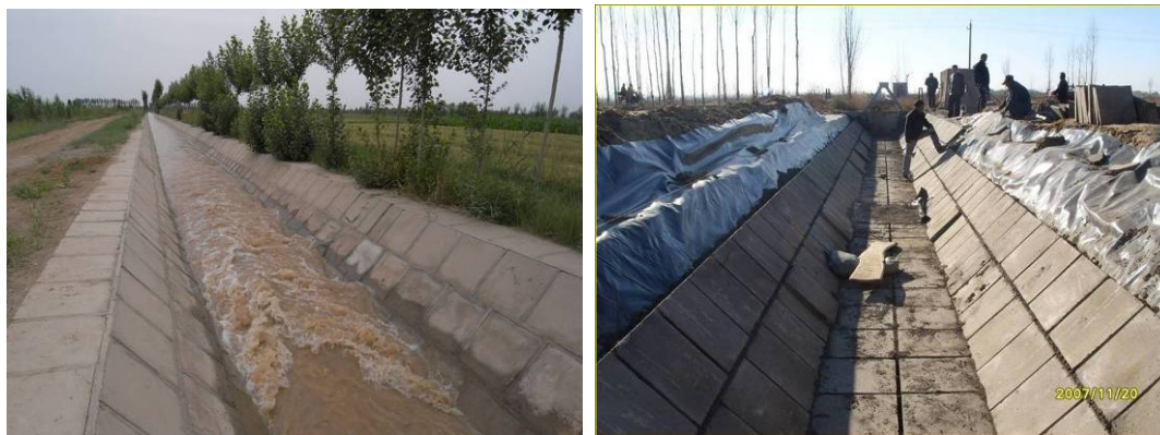
图 3-41 公安斗渠土壤固化板施工与灌溉运行（2007 年）
