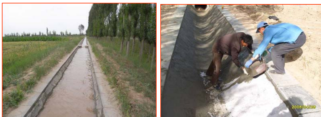
图 3-45 农渠膨润土防水毯衬砌施工与灌溉运行（2007 年）
