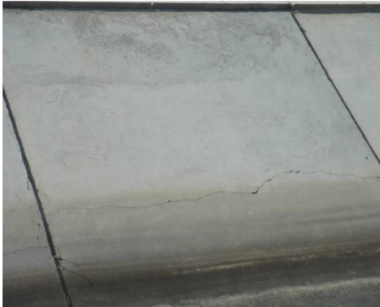
图 2-1 混凝土衬砌板冻胀裂缝照片（1）
