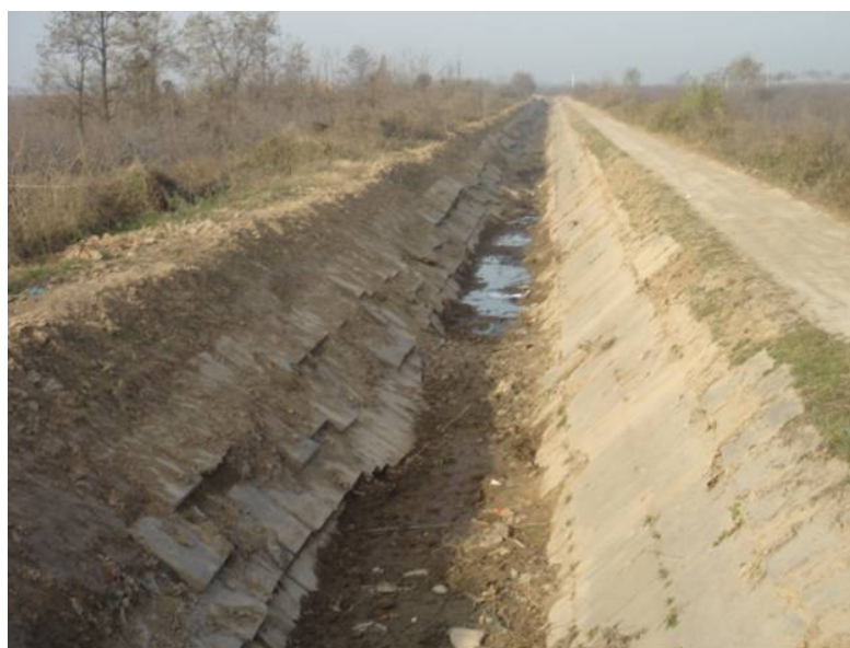
图 2-6 渠坡基土冻融滑坡导致预制混凝土板滑塌破坏照片 (1)
