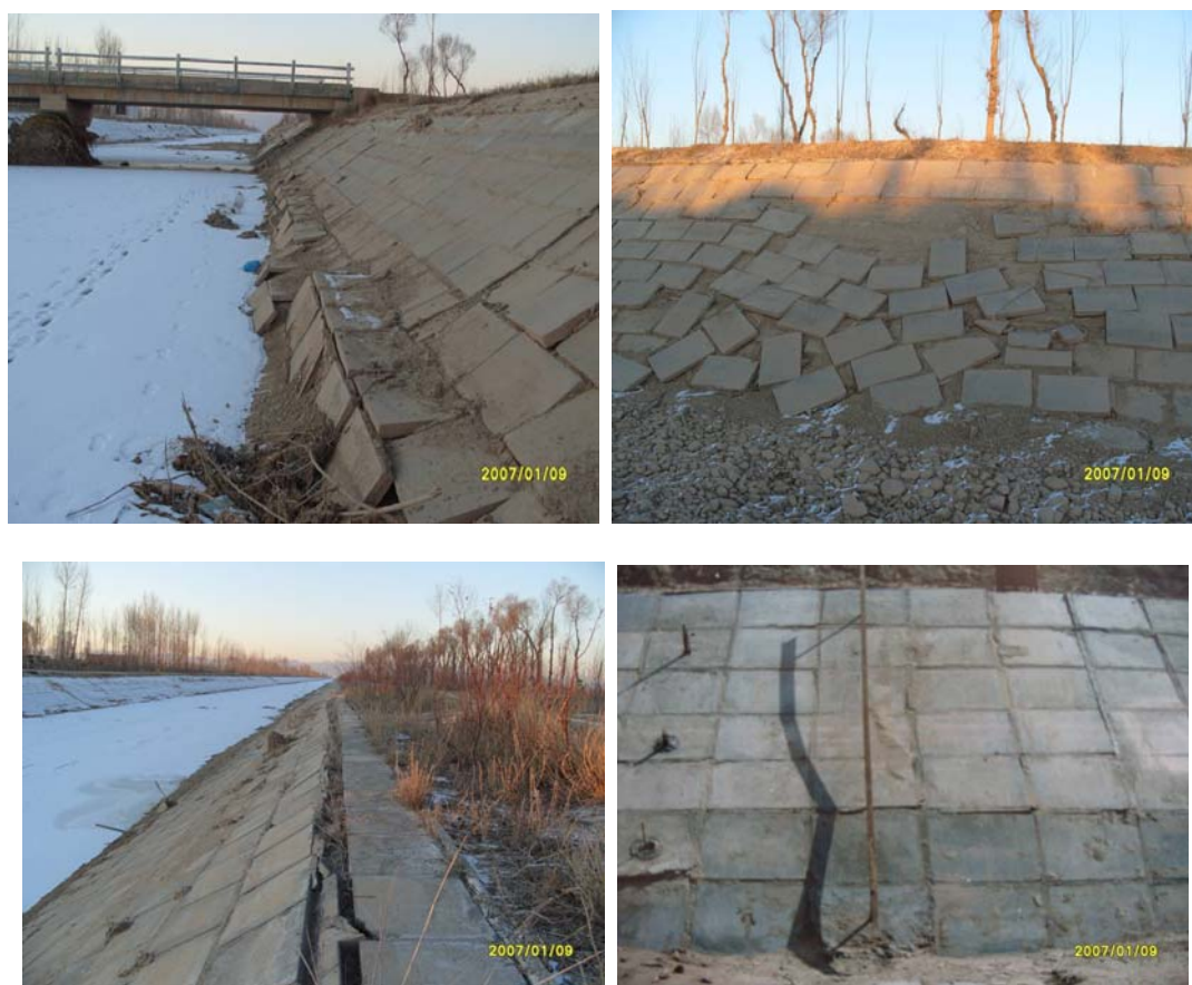
图 3-46 杨家和干渠未采取保温措施的试验段冻胀破坏情况
