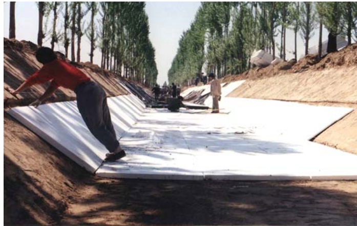
图 3-36 西济支渠聚苯乙烯保温板铺设
