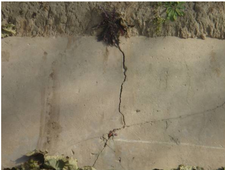
图 2-2 混凝土衬砌板冻胀裂缝照片（2）
