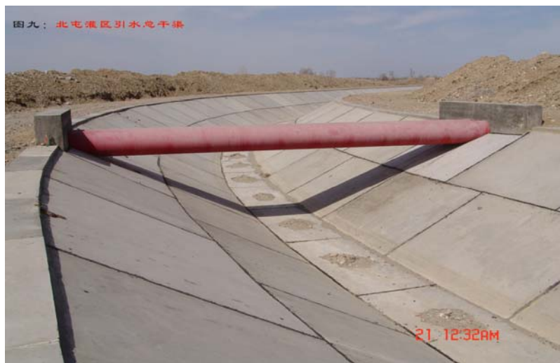
图 3-3 防渗衬砌后的北屯灌区总干渠（已运行 7 年）
