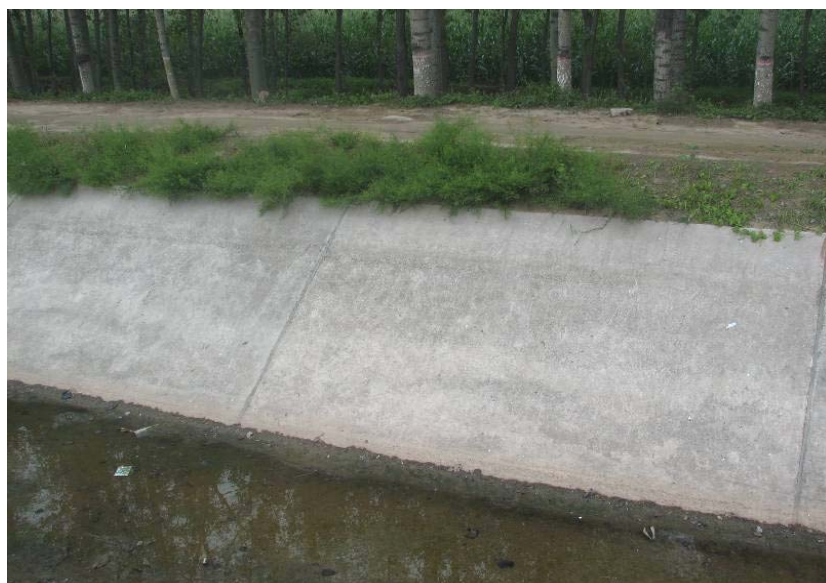
图 3-55 一千五分干渠混凝土防渗工程实景图（ 8\text{cm} 厚）
