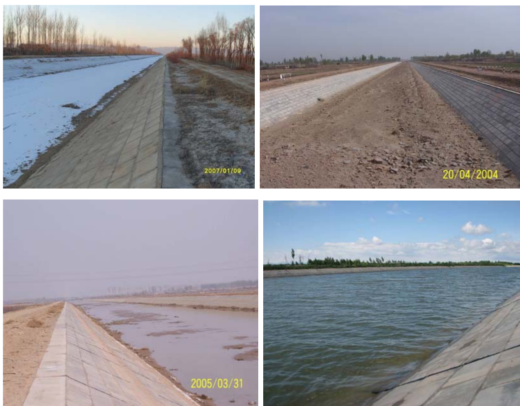
图 3-47 杨家和干渠采取保温措施的试验段
