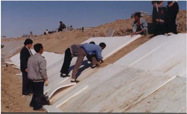
图 3-35 永刚分干渠渠坡采用聚苯乙烯保温板防冻措施
