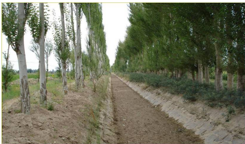
图 3-42 隆胜节水示范区西济渠右五斗渠土壤固化板+塑膜衬砌（1999 年施工）
