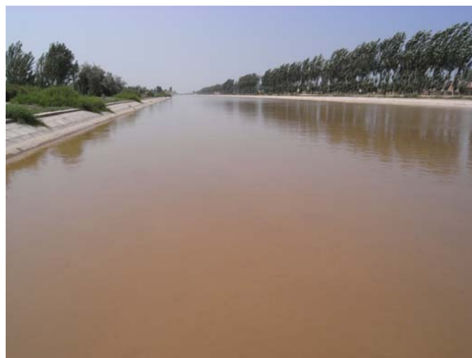
图 3-37 永济干渠采用全断面聚乙烯膜防渗，聚苯保温板防冻
