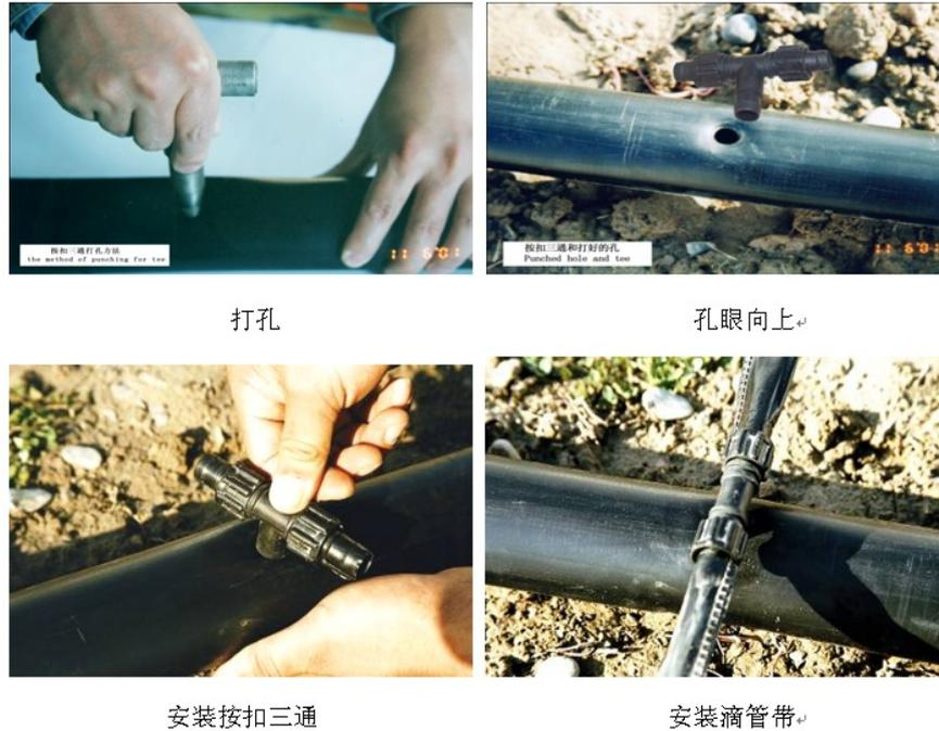
图 4.24 滴灌带与支、辅管连接步骤示意图
