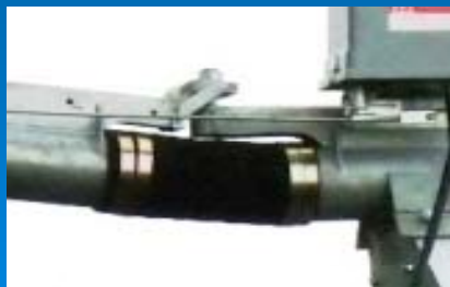
跨间柔性连接
