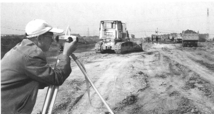
工程技术人员正在和县双桥河堤防加固现场测量施工高程 汪国庆 摄
