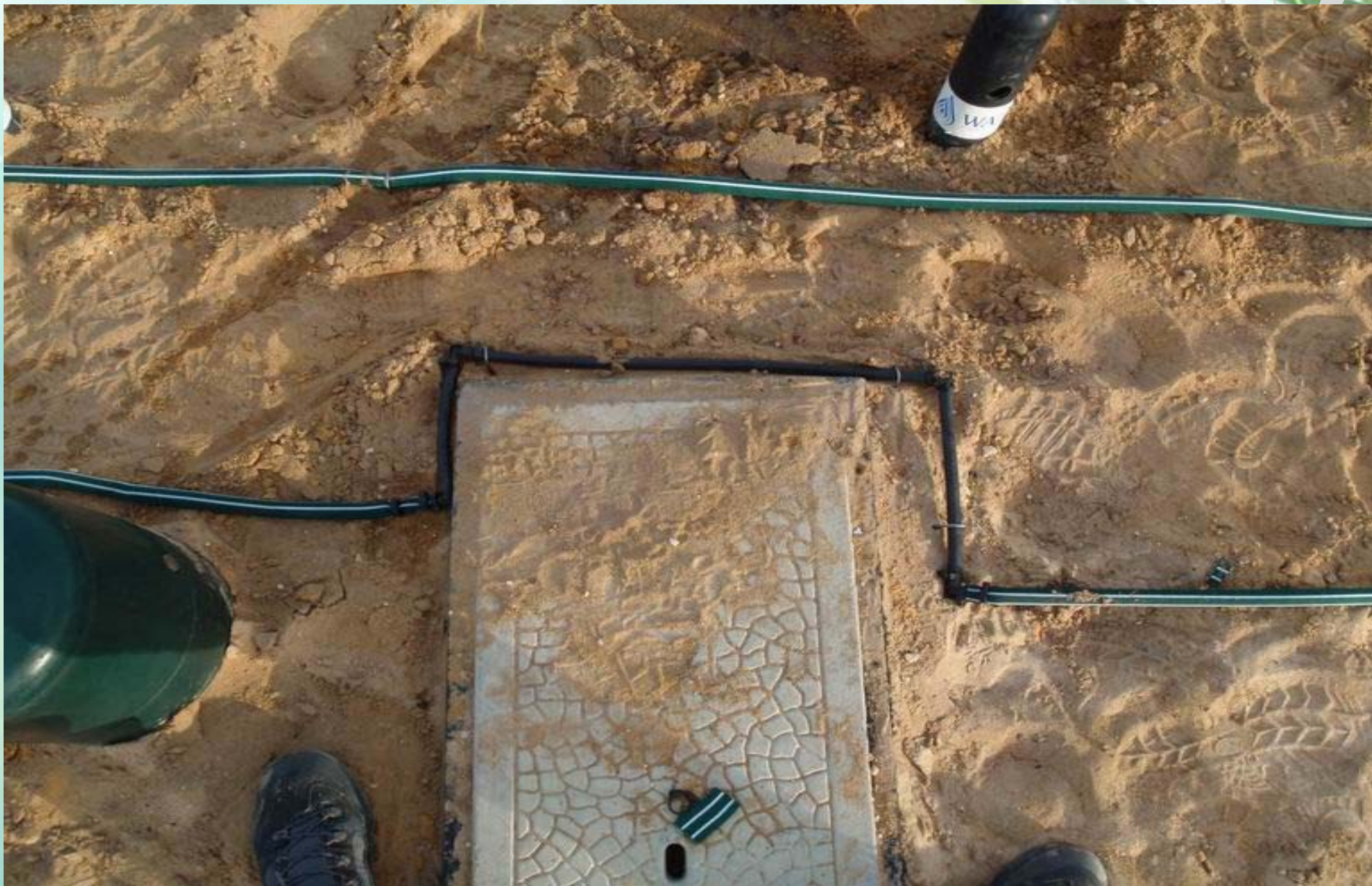
铺设用于草坪的微润管
