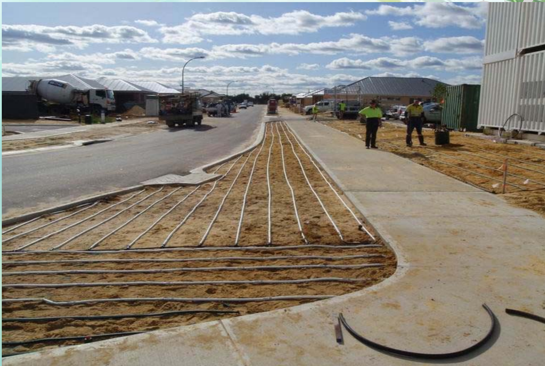
澳洲某小区上，正在铺设微润管
