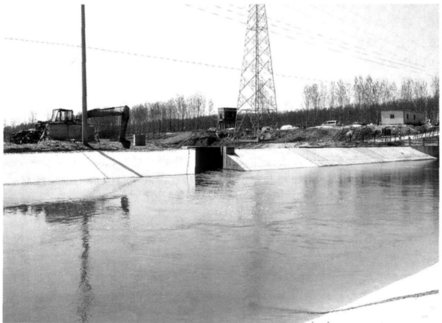
田山灌区与济平干渠连通工程
