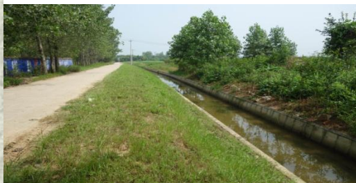
维护后的芮店支渠过岗分支渠
