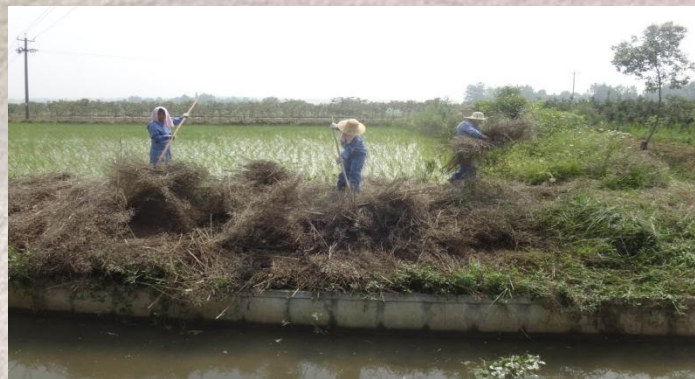
养护队员在芮店支渠过岗分支渠清杂
