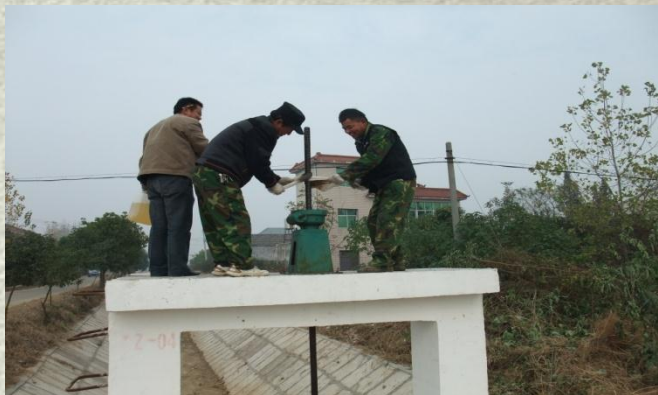
养护队员在芮店西支渠节制闸进行机械保养
