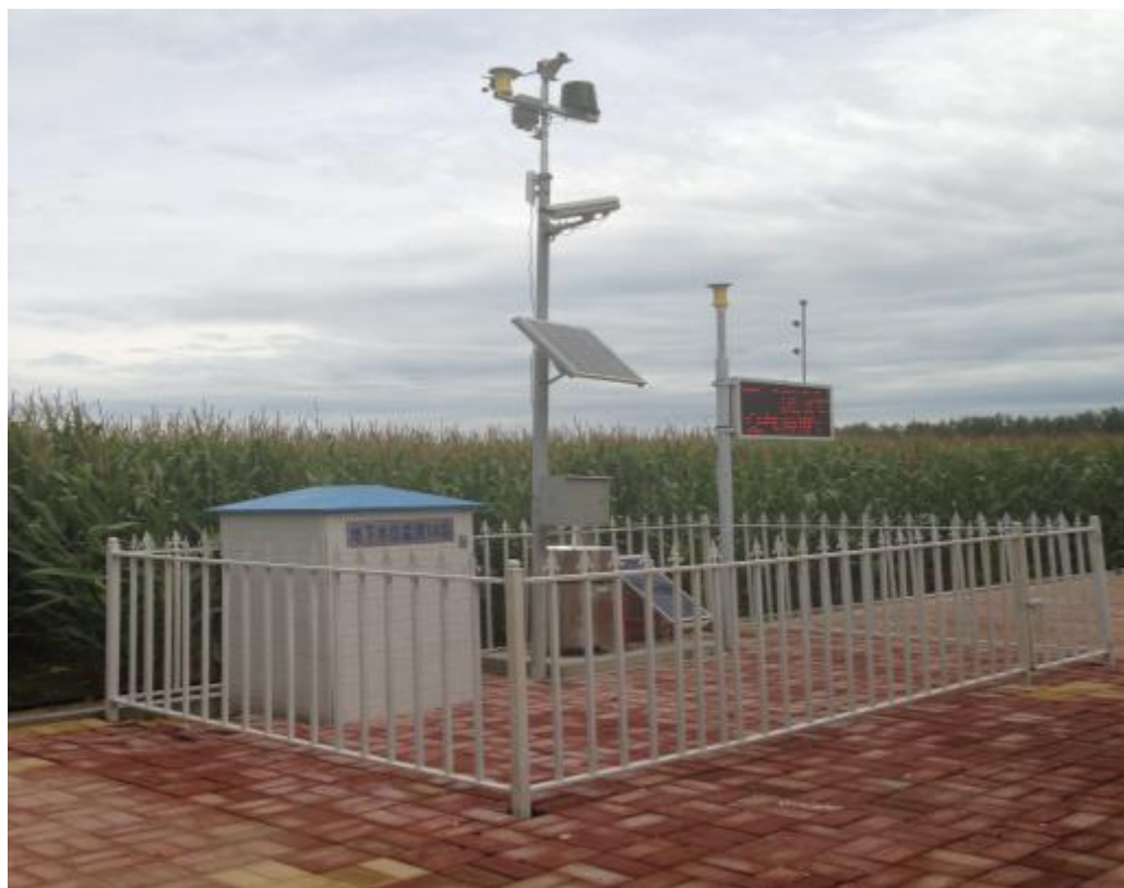
地下水位监测终端
