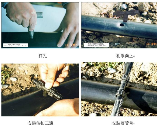
图 15 滴灌带与支、辅管连接步骤示意图
