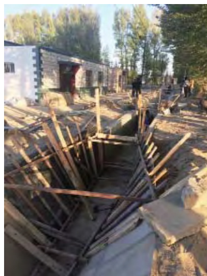
金塔县标准量水断面施工
