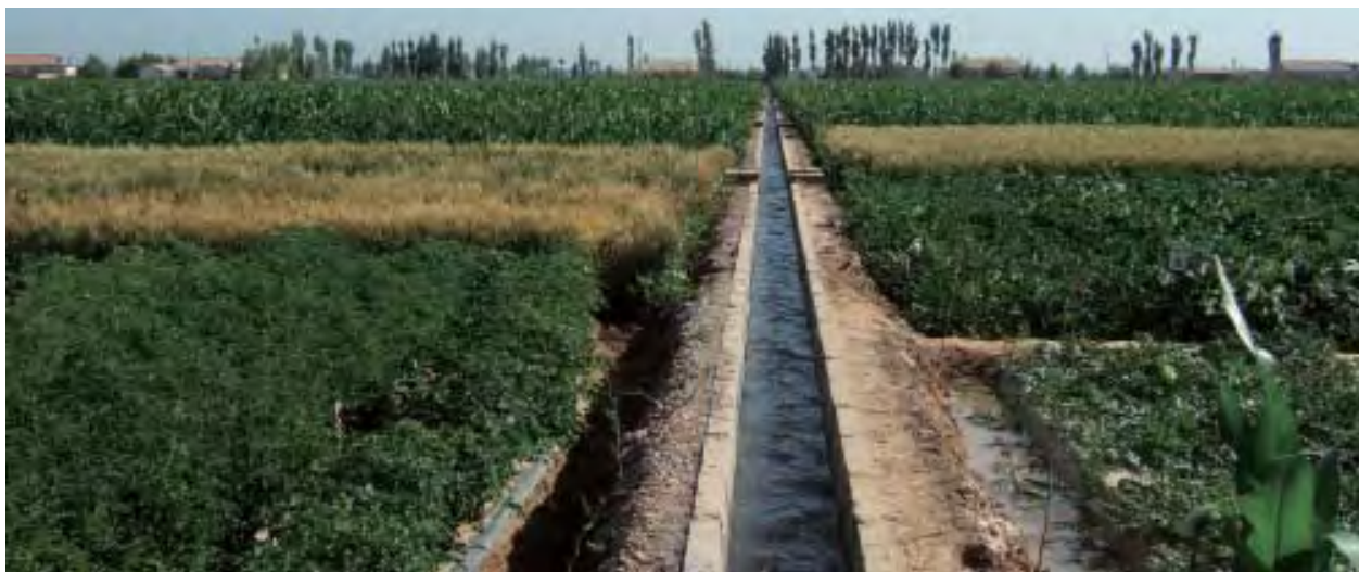
高台县斗渠工程
