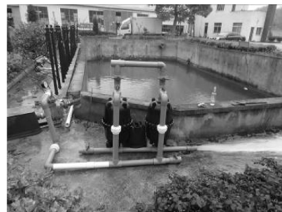
图 4 上下复合型砂石-滤网集成式过滤器正常工作状态
