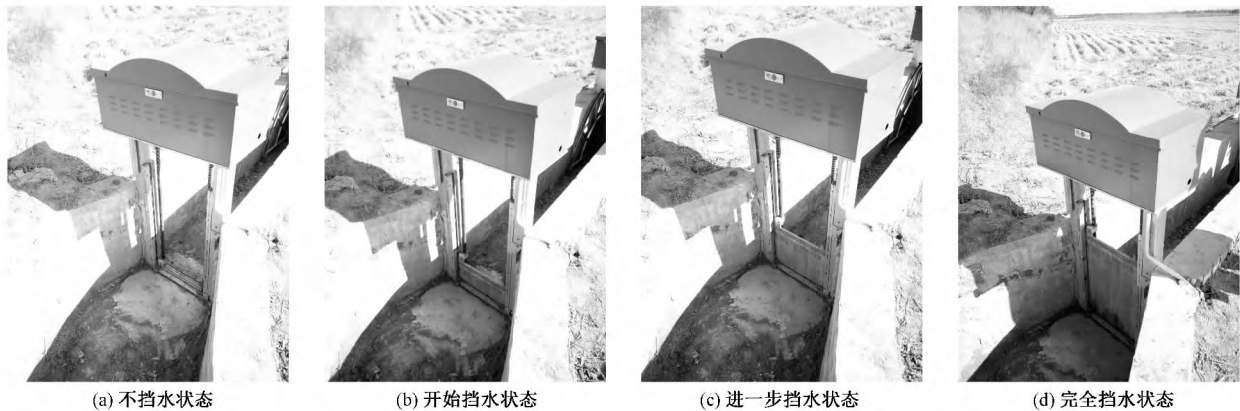
图2 底升式测控一体化控水设备工作状态
