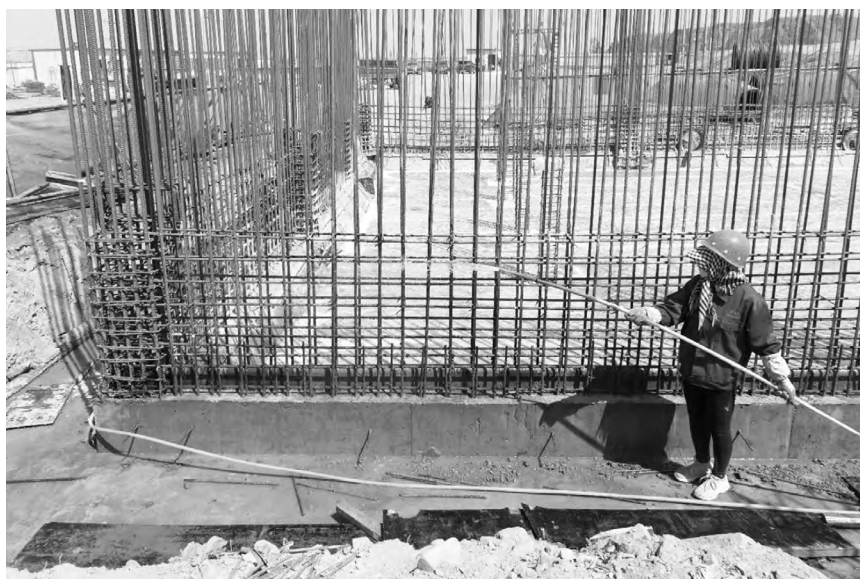
沙坡头河南地区农村饮水安全巩固提升工程净水厂施工
