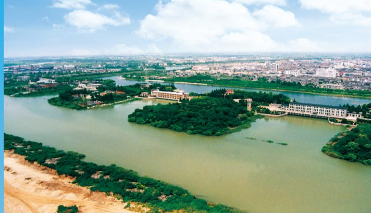
重点泵站工程——江苏江都排灌站
