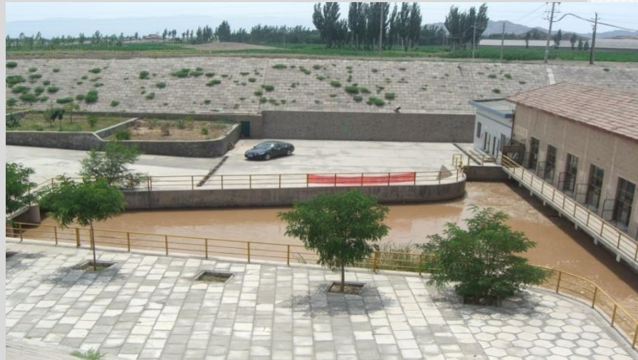
改造后正向进水前池
