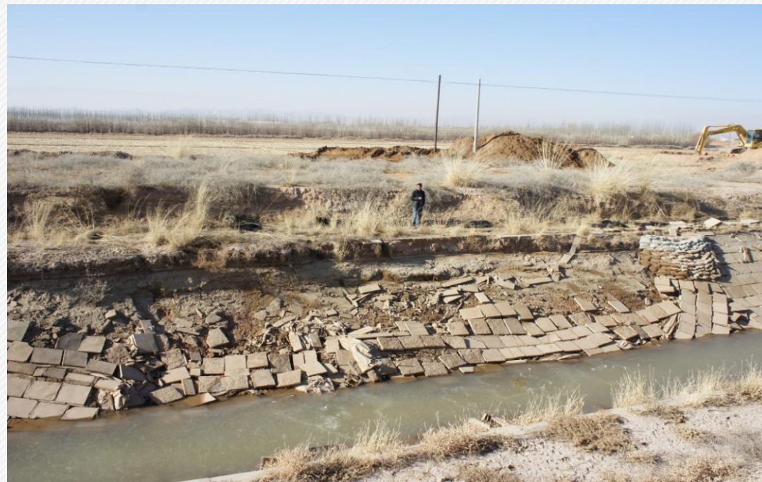
改造前的渠道
