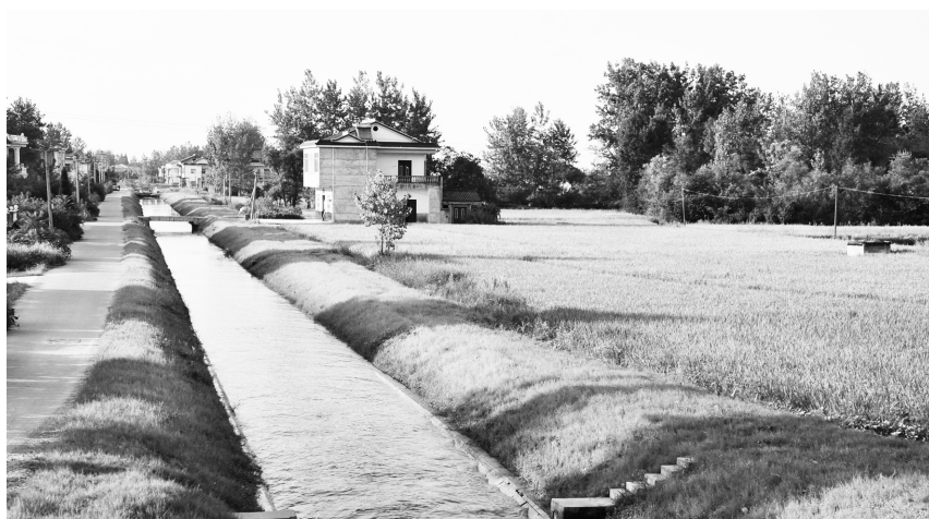
淠史杭灌区续建配套与节水改造解决了农田水利建设“最后一公里”问题。图为淠河灌区张寿支渠
