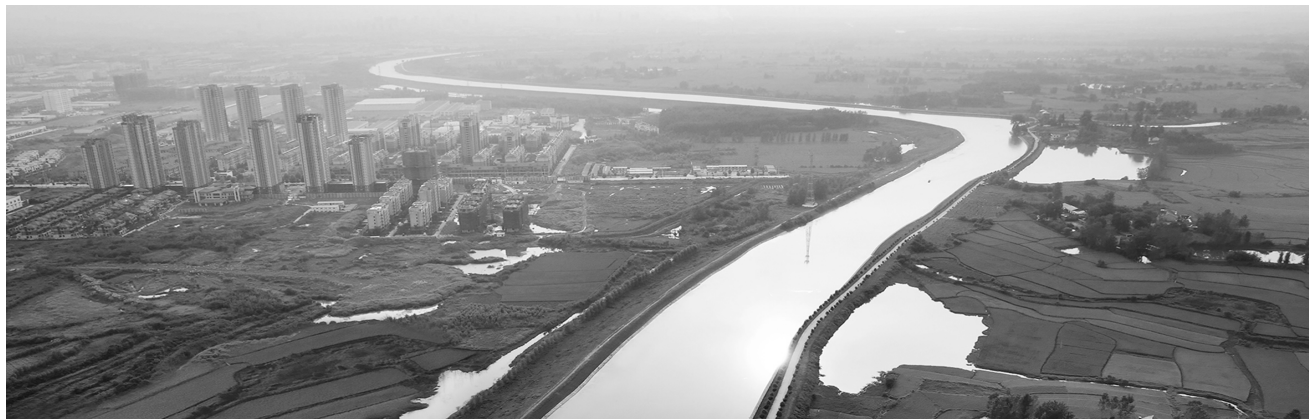
淠河总干渠全长104.5 km,承担着向合肥、六安城市和农业供水任务。图为淠河总干渠三十铺段
