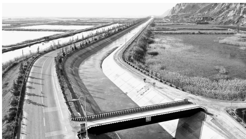
陕西省渭南市东雷抽黄总干渠标准化规范化建设
