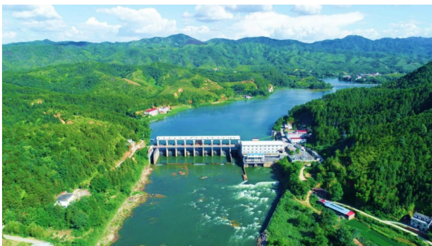
2021年绿色小水电示范电站——江西省赣州市留金坝水电站
