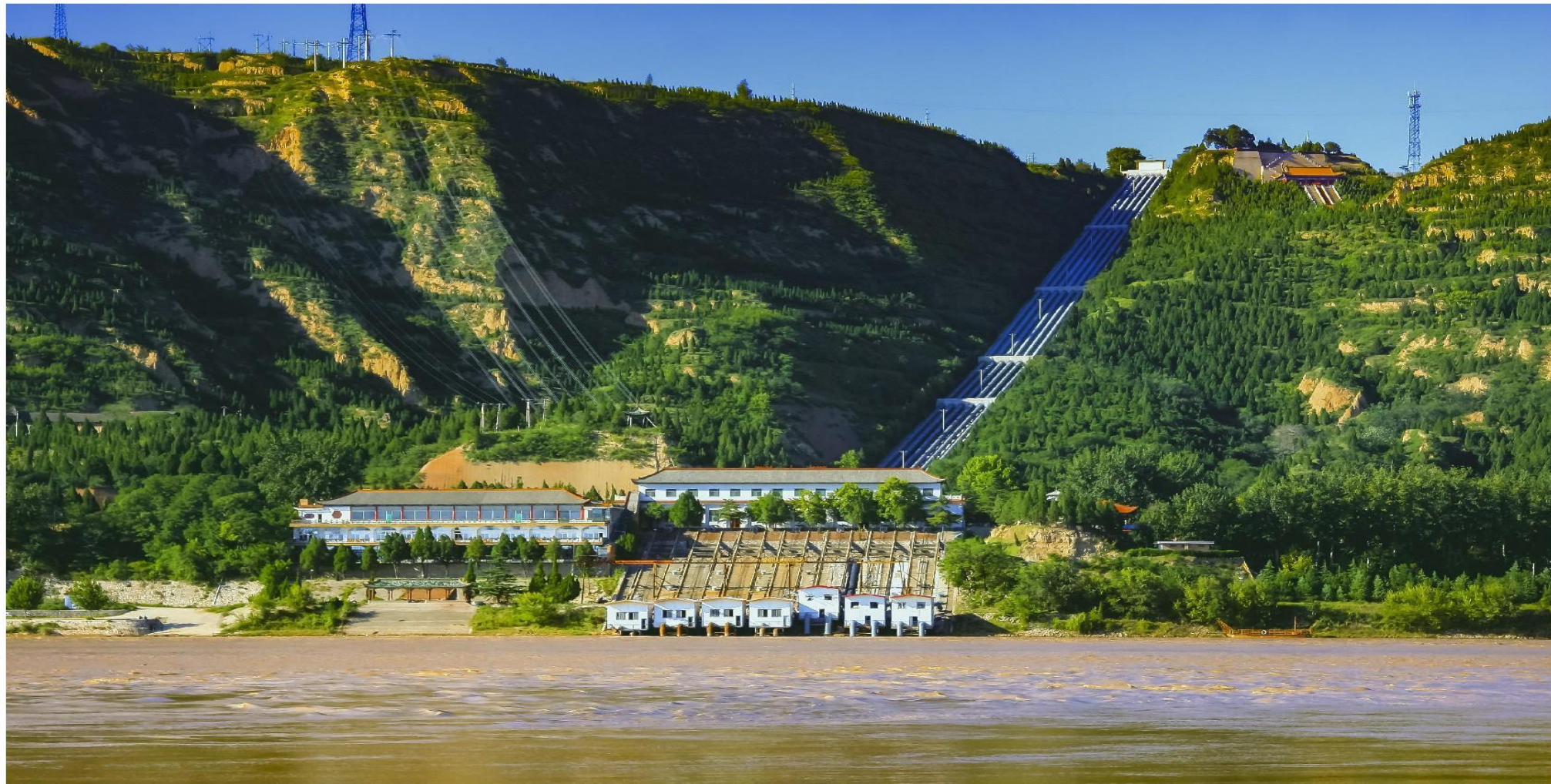
大禹渡水源站全貌
