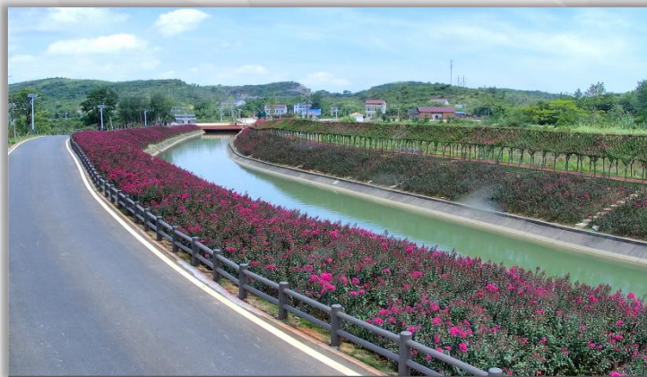
双牌水库灌区
